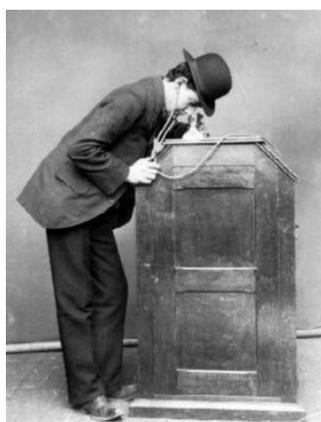
**Зритель и конструкция кинетоскопа Эдисона**
